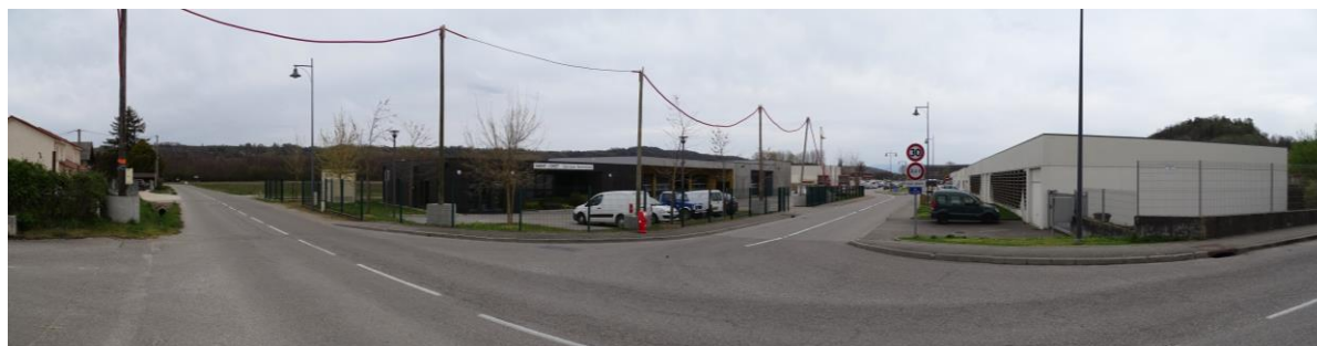
Intersection entre la RD 54 (route de Chamont) et la voie du collège
